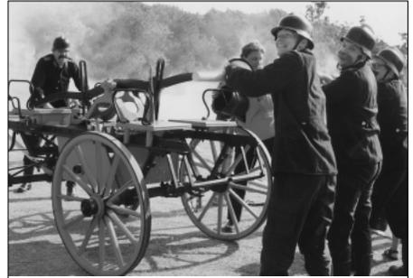
Nachgestellte Übung mit einer Handdruckspritze anlässlich der Duhner Wochen. Dieses Bild läßt erahnen, welche Erleichterung eine Motorspritze bedeutete.
